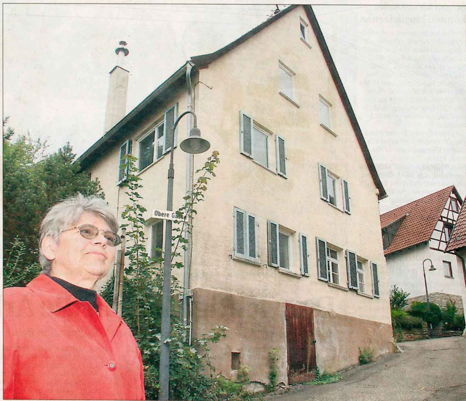
Karin Kohler vor dem Haus, in dem Hermann Wißmann einst wohnte. Hier wird auch der Stolperstein verlegt.
